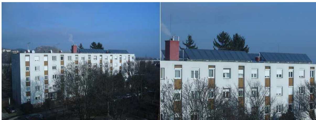
4.1.8. ábra Tömbfűtéshez kapcsolódó napkollektorok lakóház tetején
