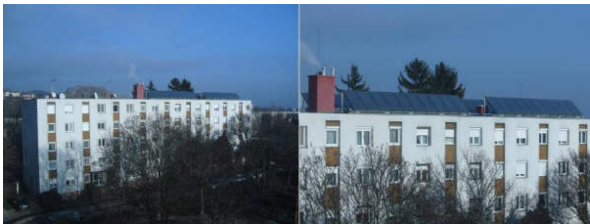
4.1.8. ábra Tömbfűtéshez kapcsolódó napkollektorok lakóház tetején
