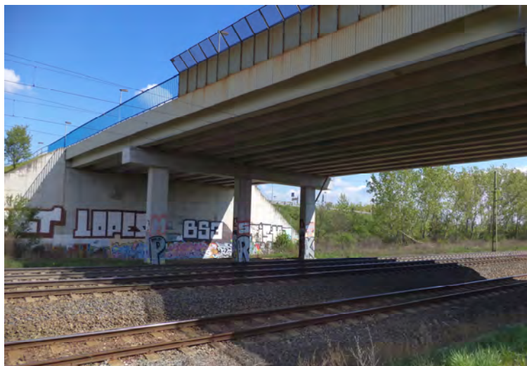
7.38. ábra Sport utcai vasúti híd
